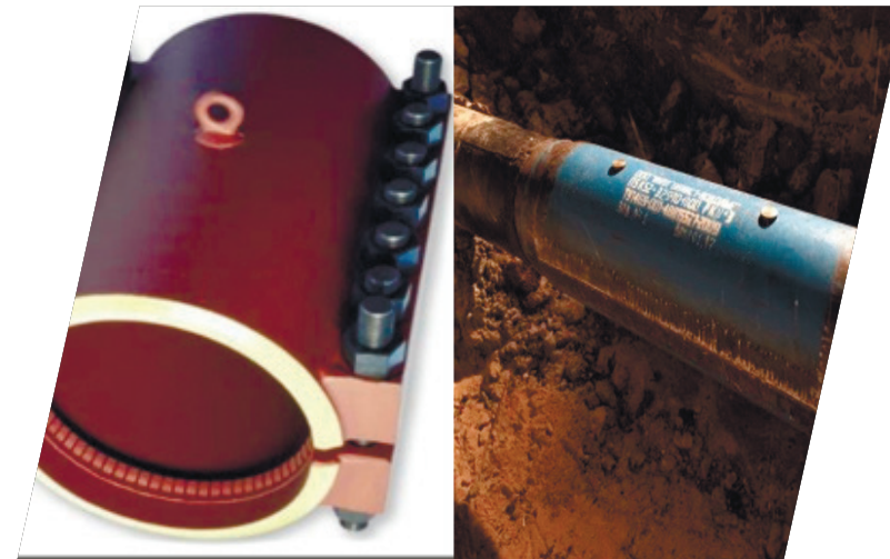
Установка металлических ремонтных конструкций- недостатки
